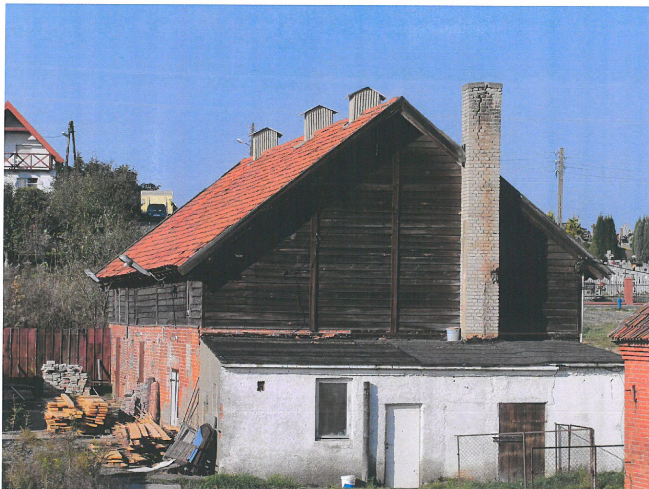
Widok ściany wzdłużnej i szczytowej (z E na W)
