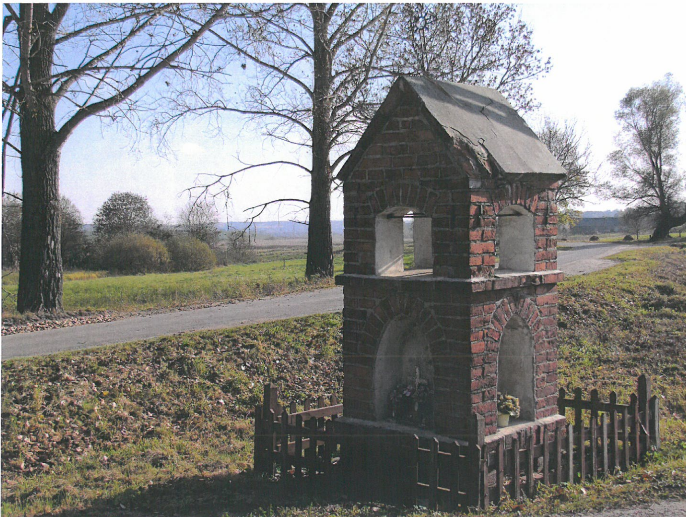
Widok ściany przedniej i bocznej (z E na W)
