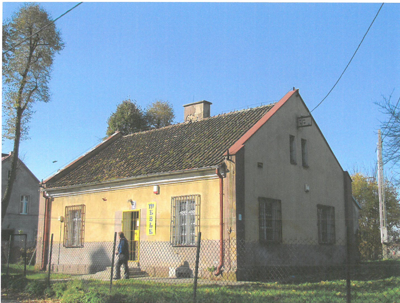
Widok ściany frontowej i szczytowej (z E na W)
