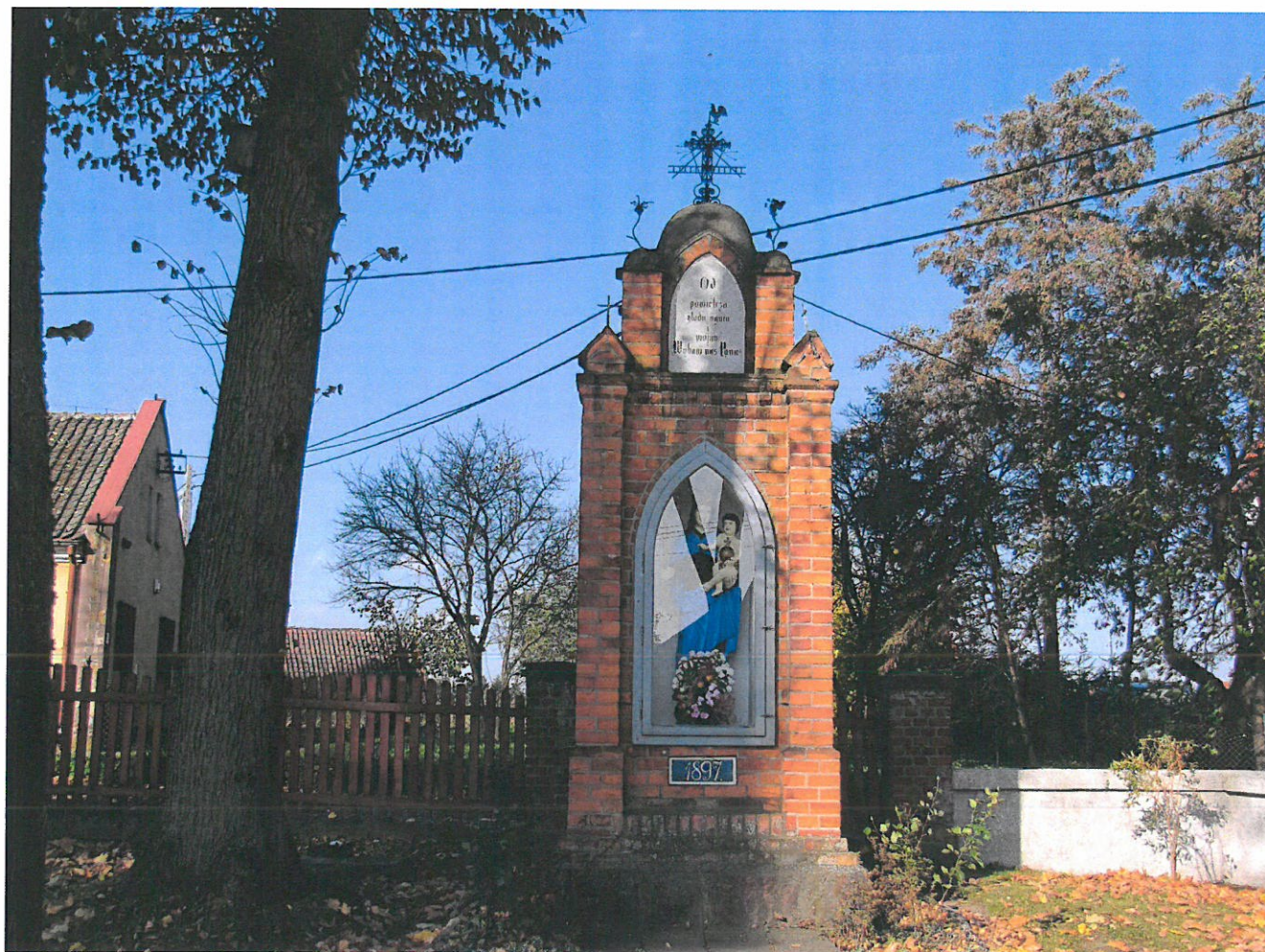
Widok przedniej ściany kapliczki (z E na W)
