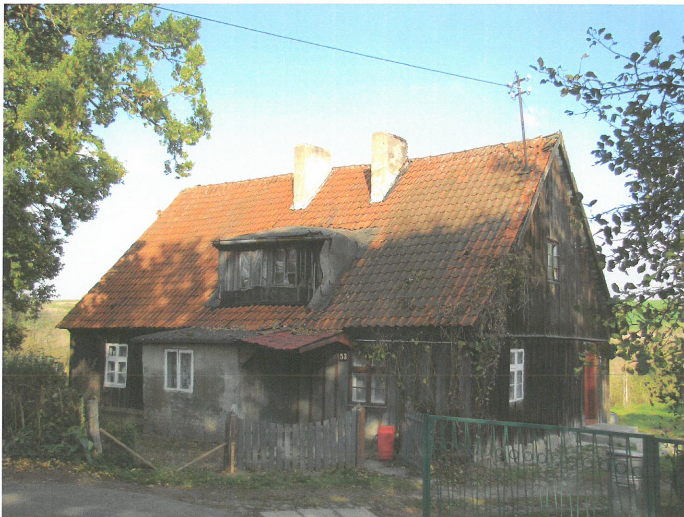
Widok ściany frontowej i szczytowej (z S na N)
