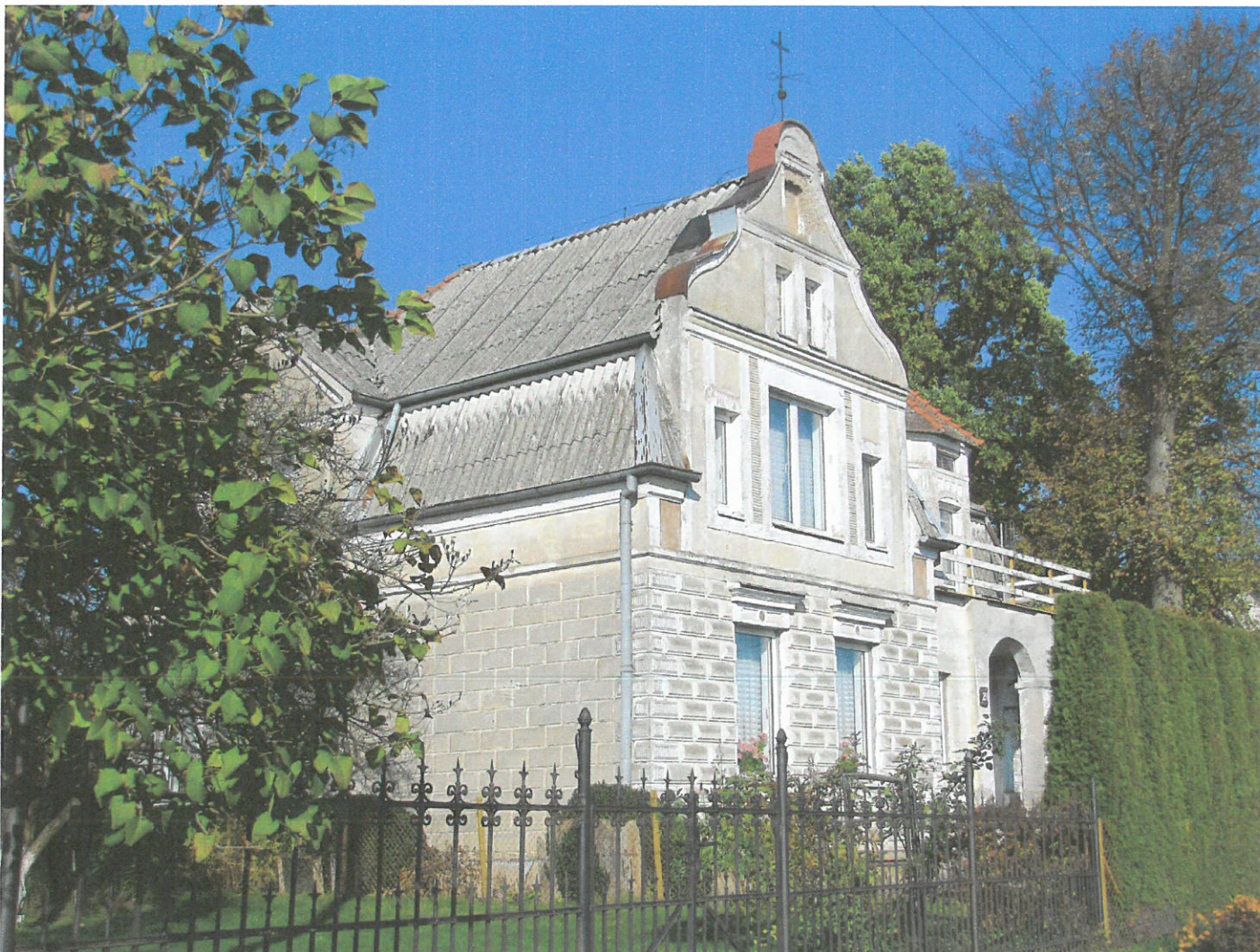
Widok ściany frontowej i szczytowej (z SE na NW)
