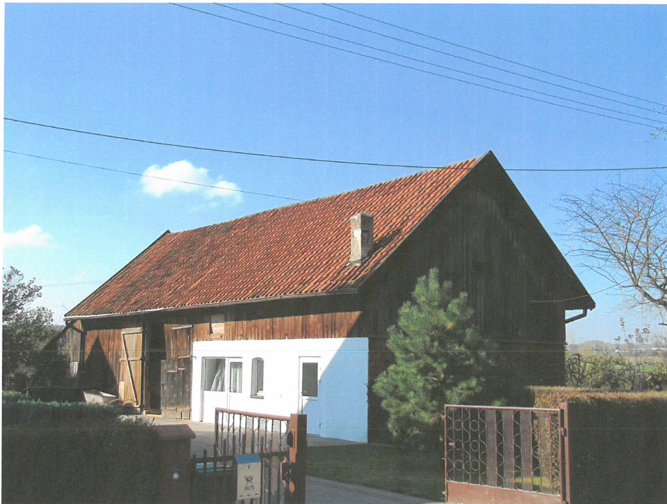
Widok ściany wzdłużnej i szczytowej (z SE na NW)
