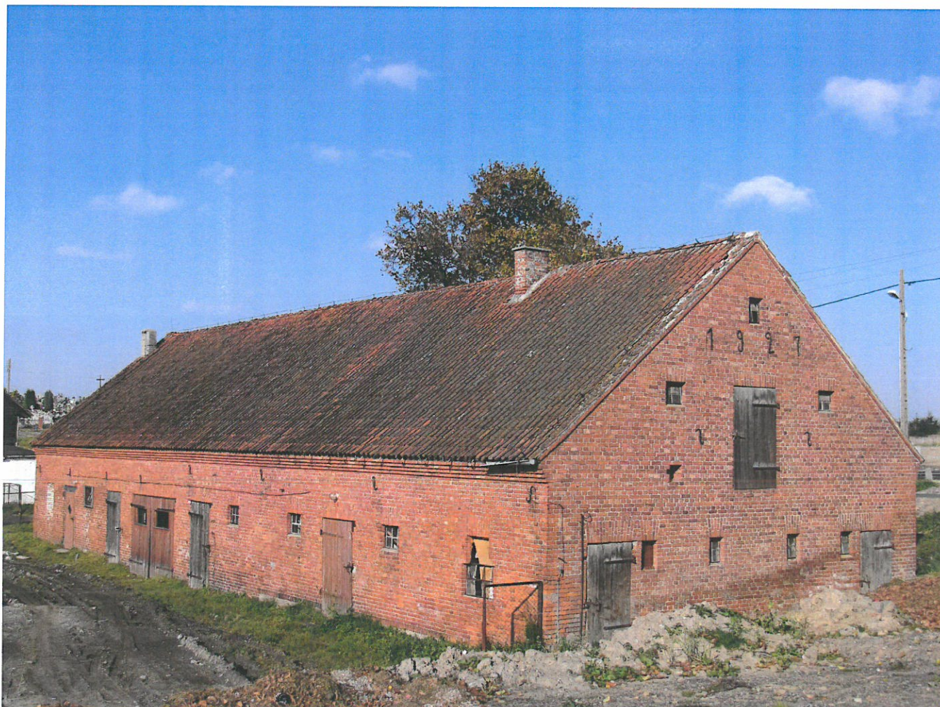
Widok ściany wzdłużnej i szczytowej (z S na N)
