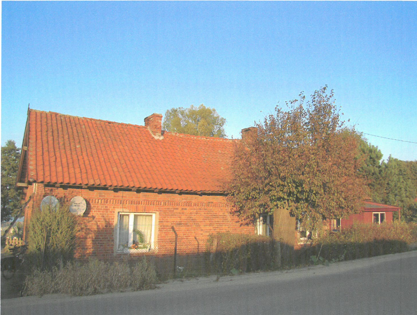
Widok ściany frontowej (z W na E)
