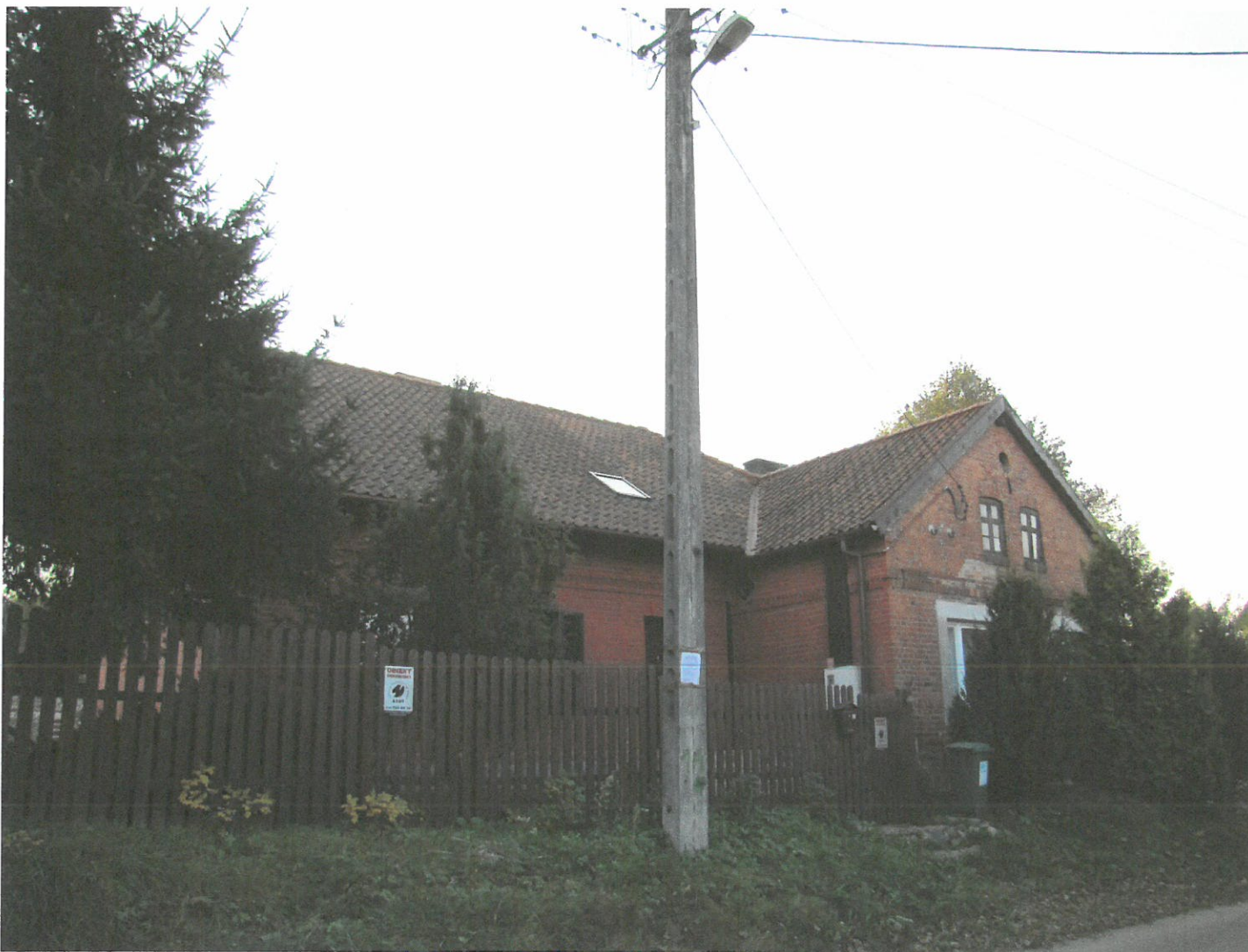
Widok ściany frontowej (z E na W)
