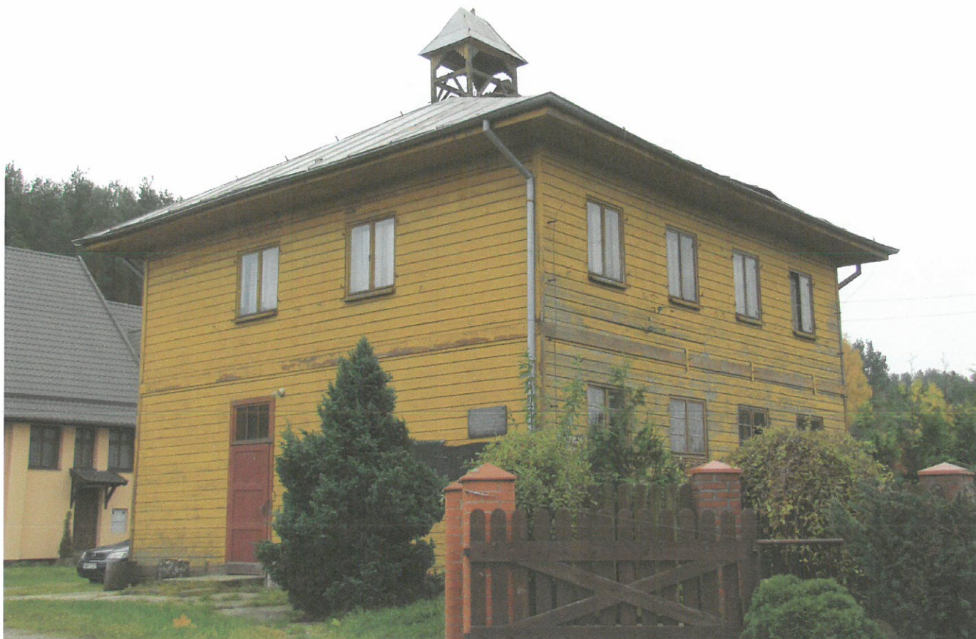
Widok ściany frontowej i bocznej (z SE na NW)
