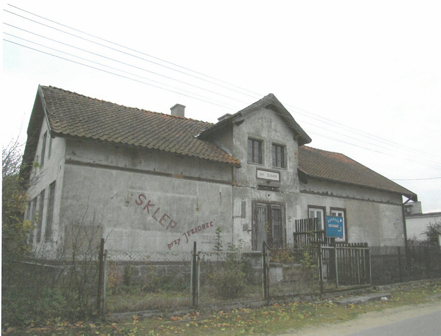
Widok ściany frontowej i szczytowej (z E na W)
