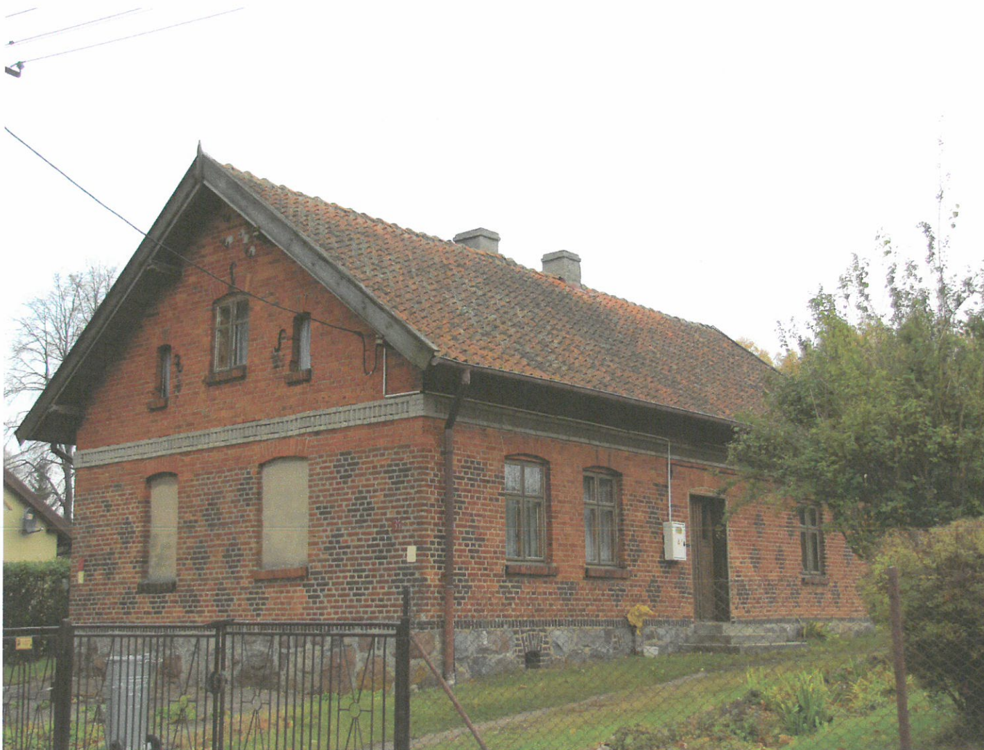
Widok ściany frontowej i szczytowej (z NE na SW)
