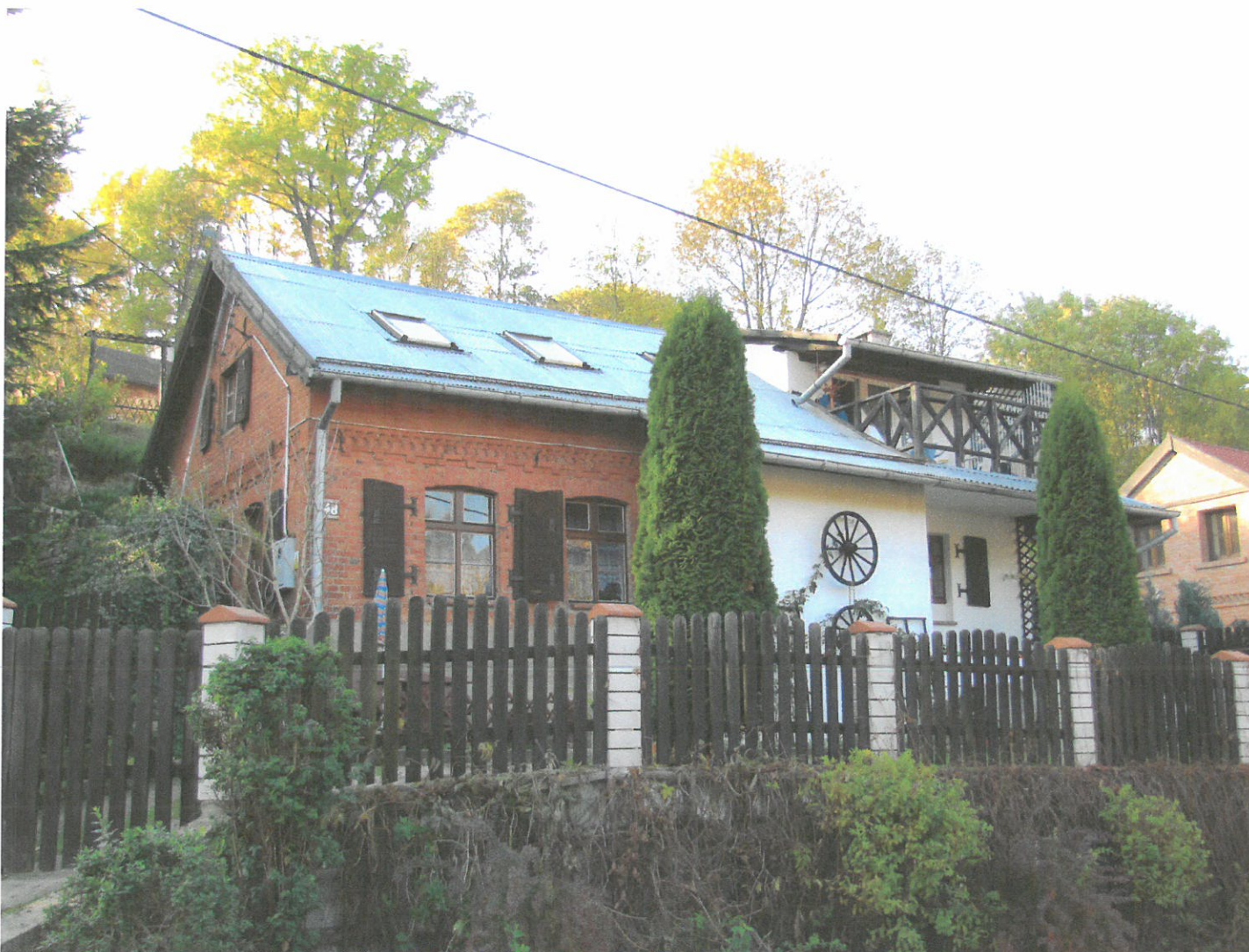
Widok ściany frontowej i szczytowej (z SE na NW)
