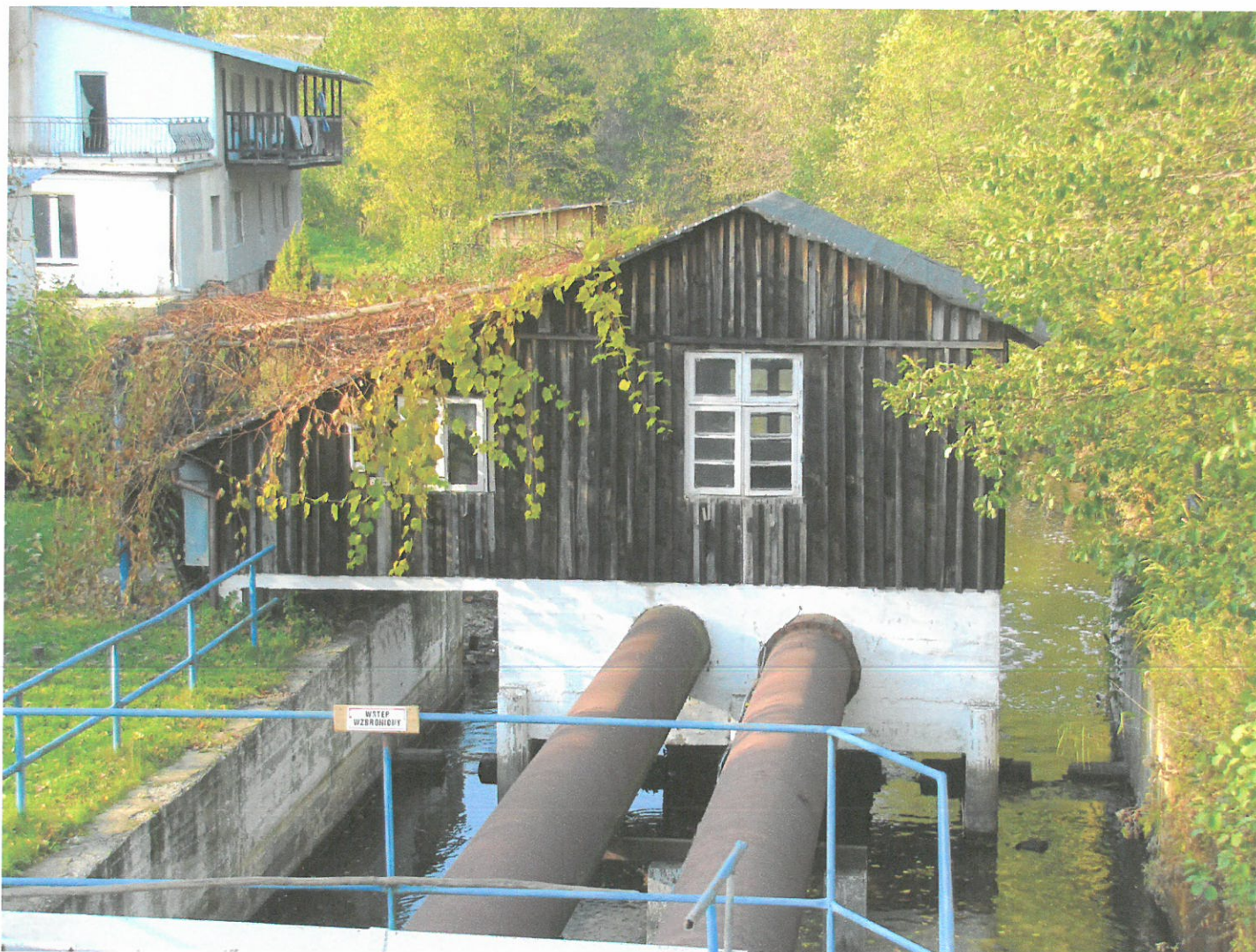
Widok ściany szczytowej i urządzeń (z SE na NW)
