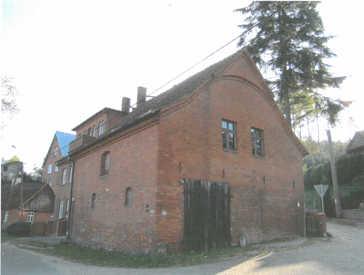
Widok ściany frontowej i szczytowej (z N na S)
