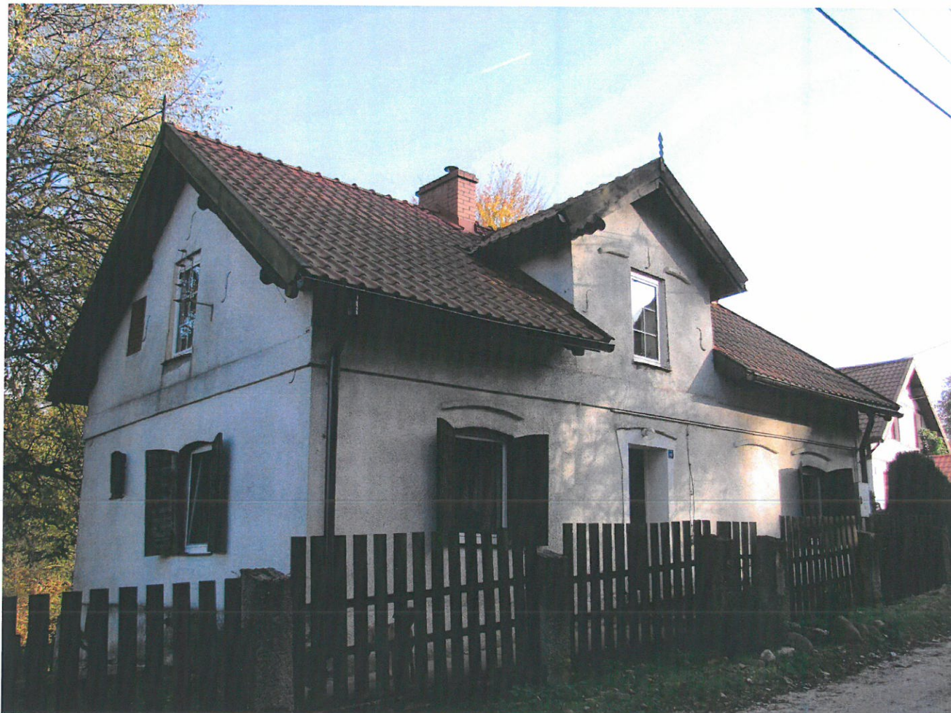
Widok ściany frontowej i szczytowej (z SW na NE)
