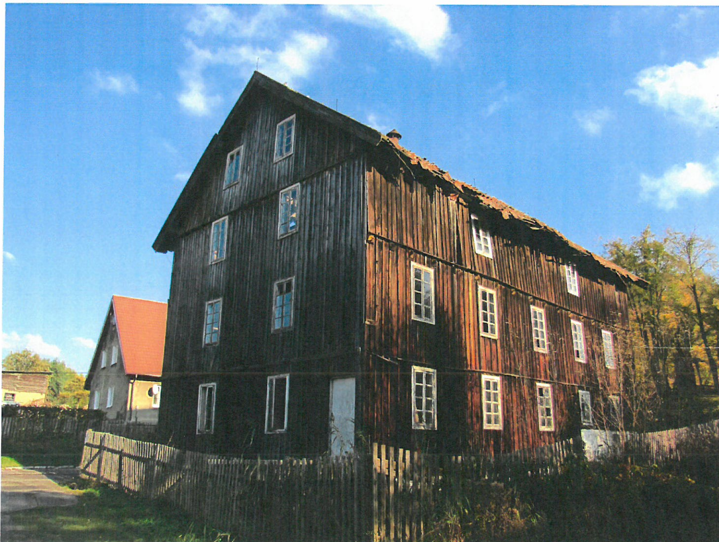
Widok ściany szczytowej i wzdłużnej (z SW na NE)
