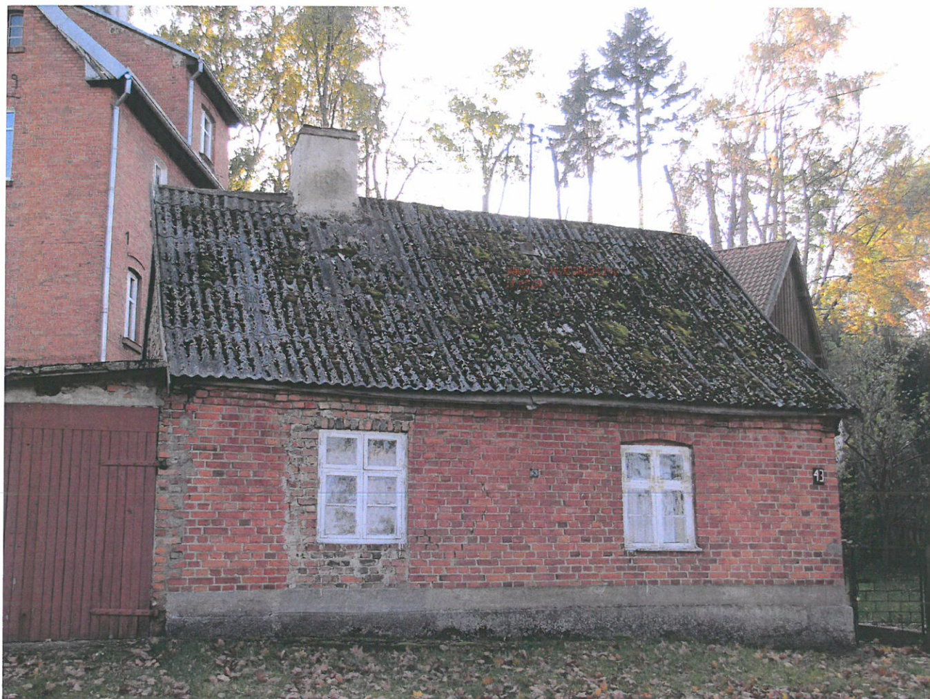
Widok ściany frontowej (z SE na NW)
