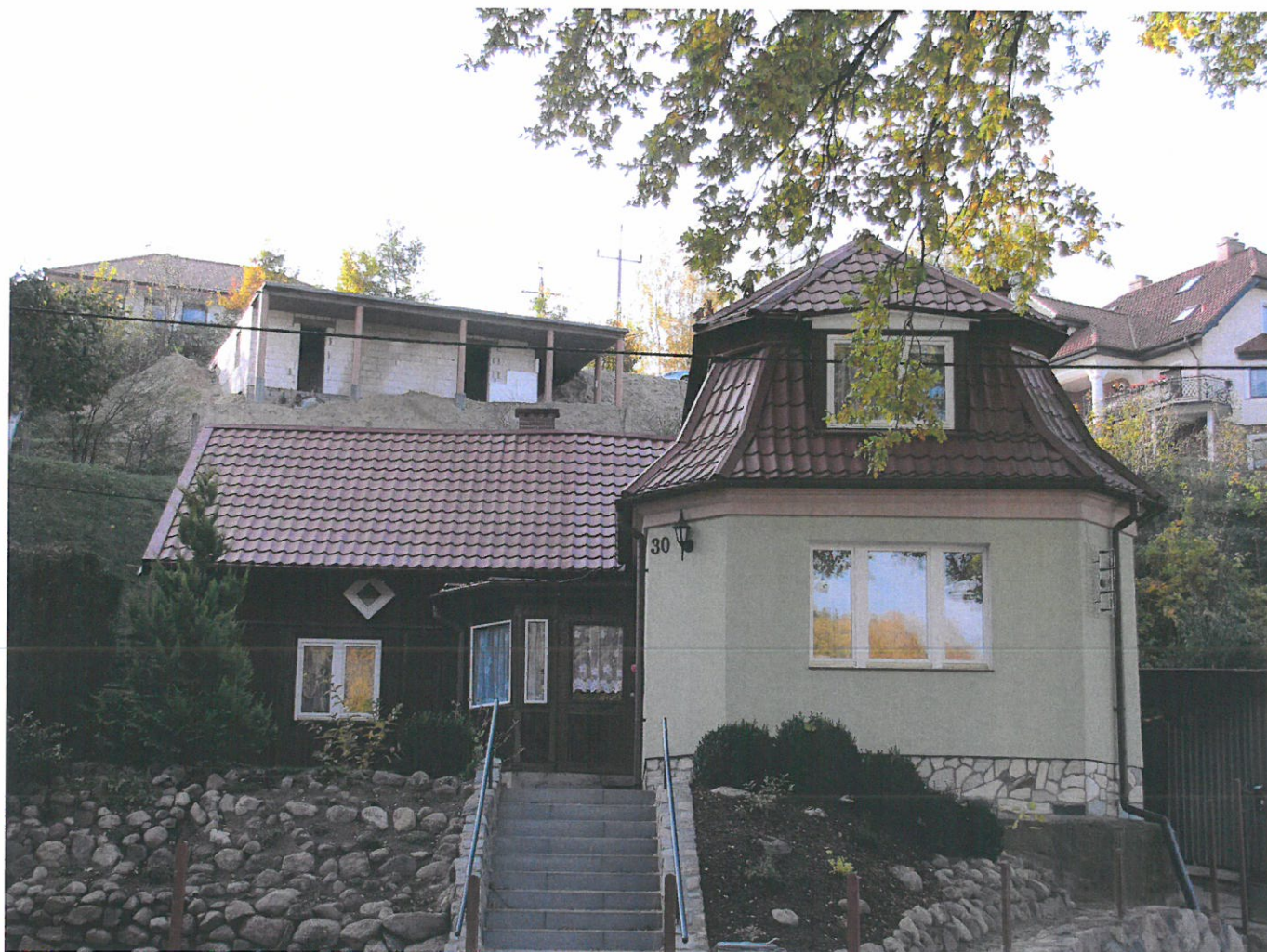
Widok ściany frontowej (z E na W)
