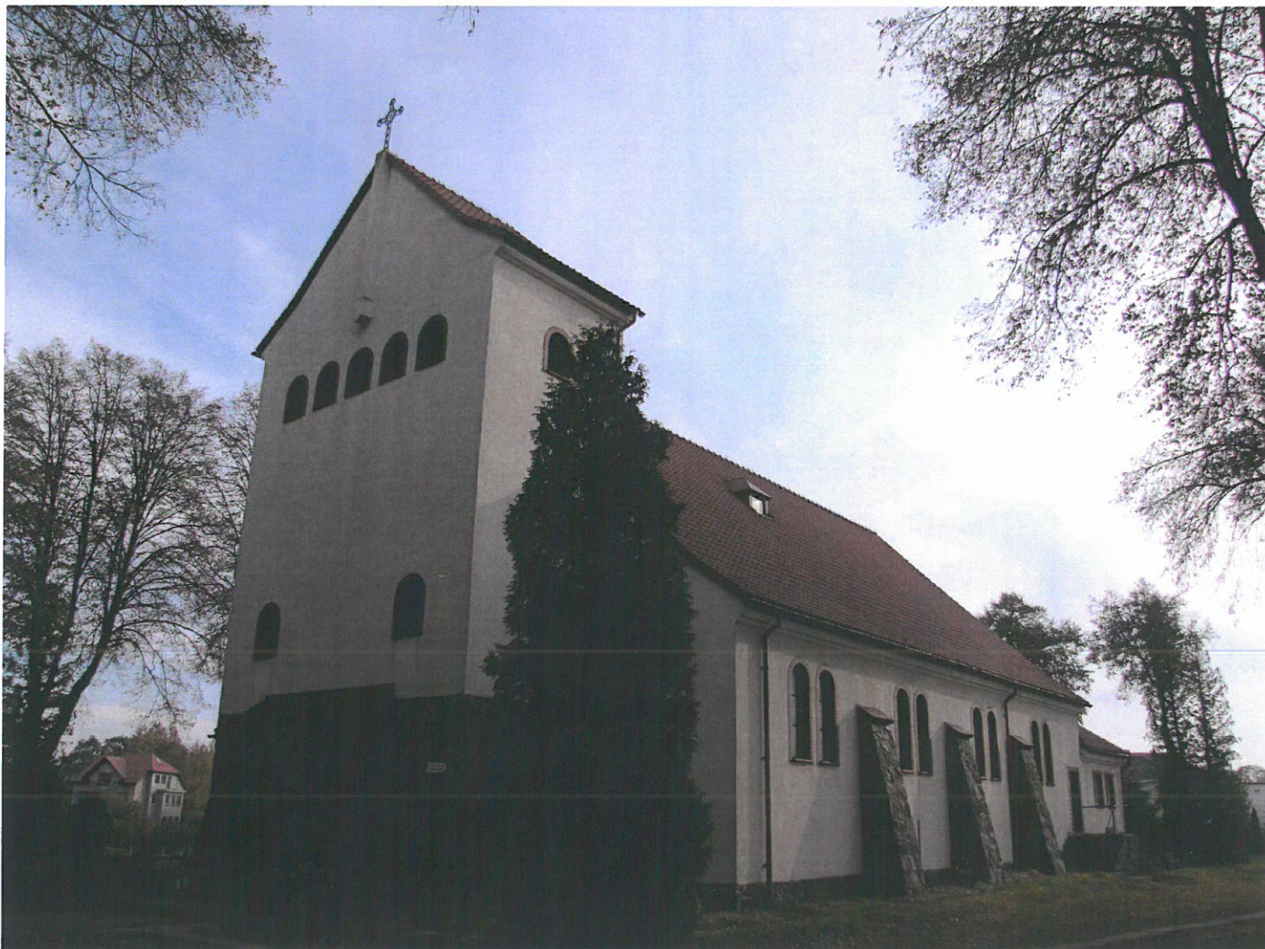
Widok ściany frontowej i wzdłużnej (z W na E)
