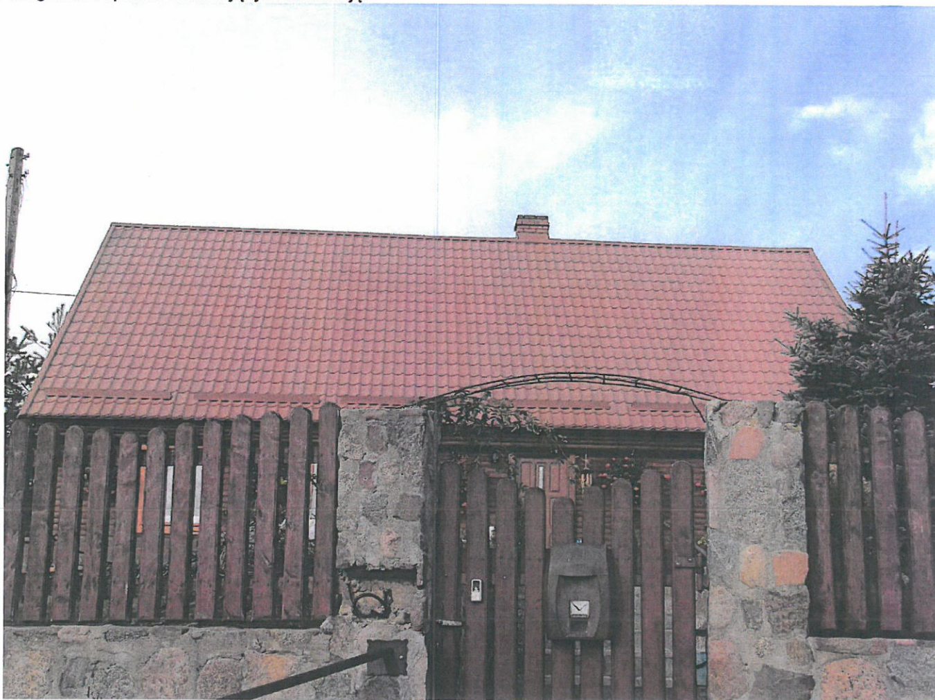
Widok ściany frontowej (z E na W)
