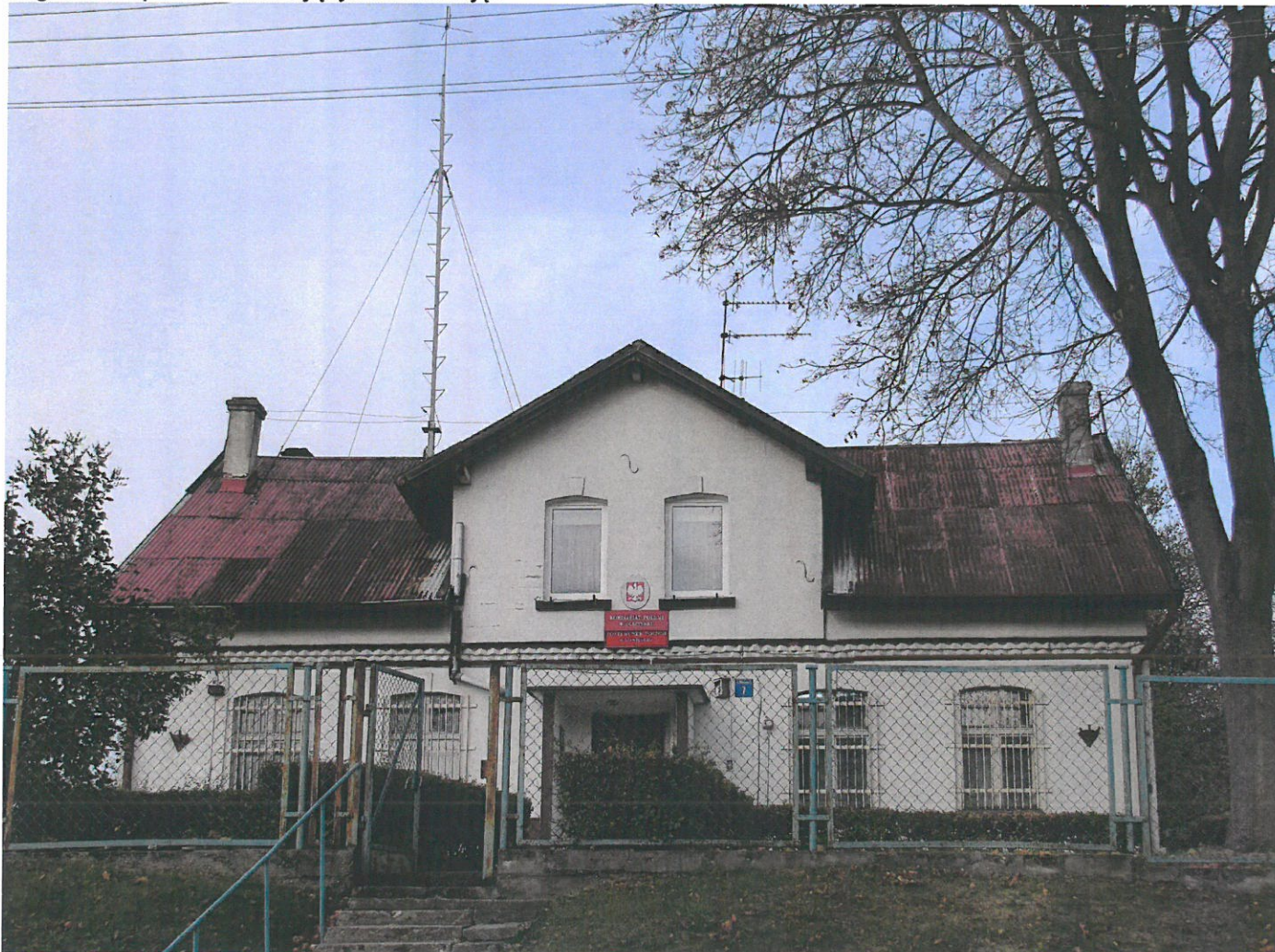
Widok ściany frontowej (z S na N)
