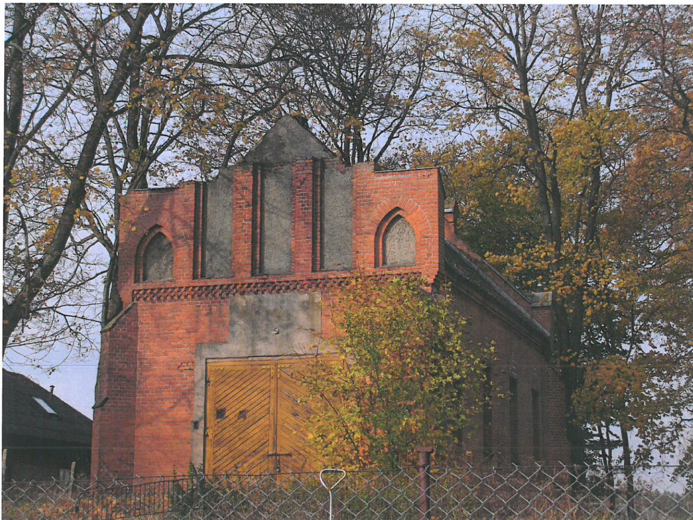
Widok ściany frontowej i wzdłużnej (z S na N)
