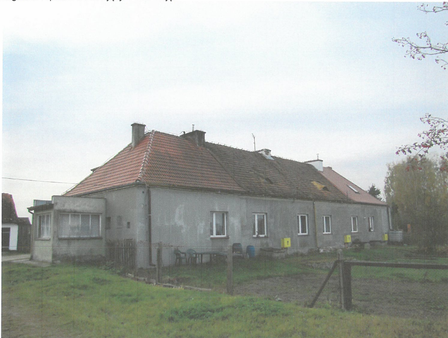
Widok ściany wzdłużnej i szczytowej (z SW na NE)
