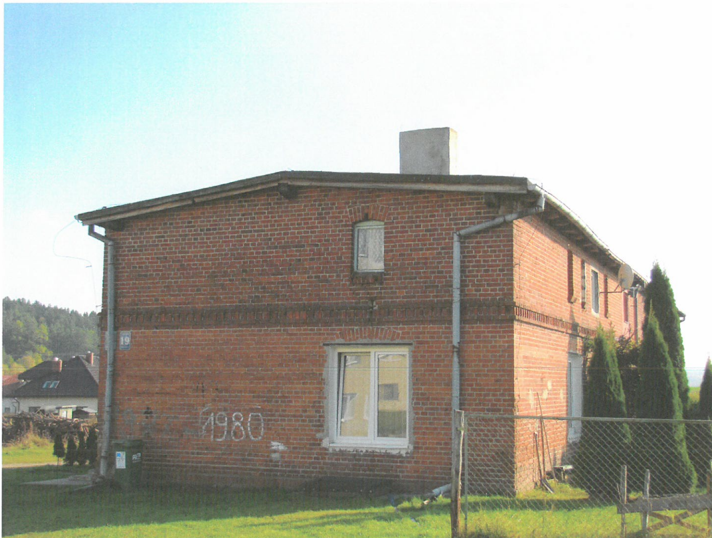
Widok ściany frontowej i szczytowej (z NW na SE)
