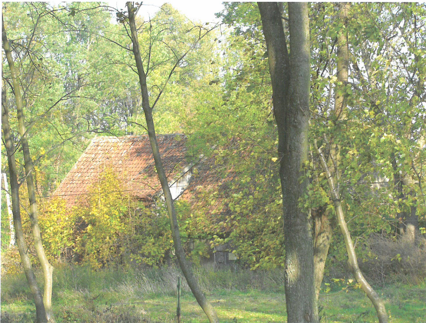
Widok ściany wzdłużnej (z SW na NE)
