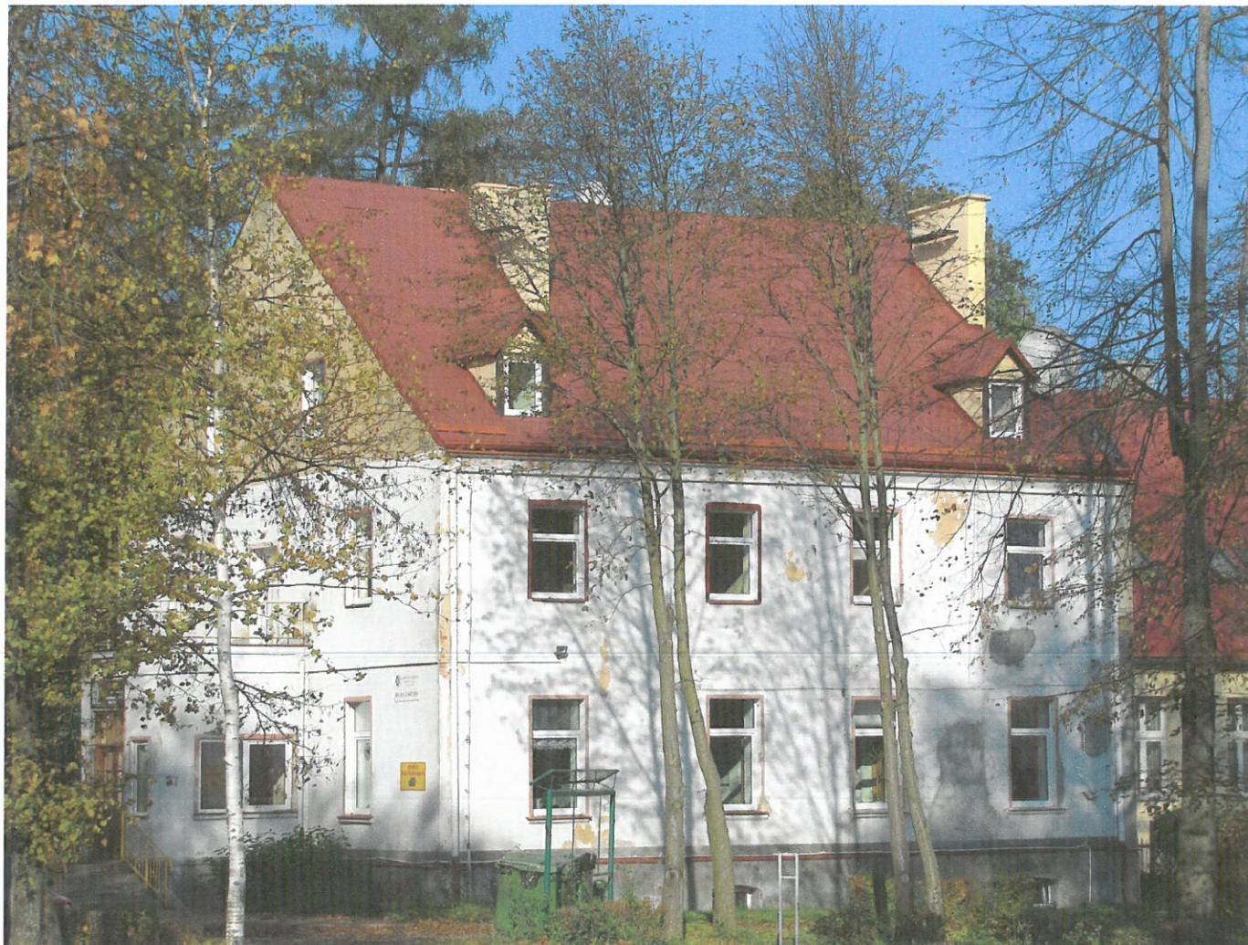
Widok fasady ogrodowej i ściany szczytowej (z SE na NW)
