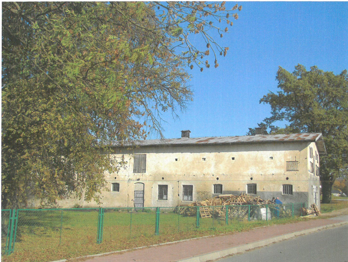
Widok ściany wzdłużnej (z W na E)
