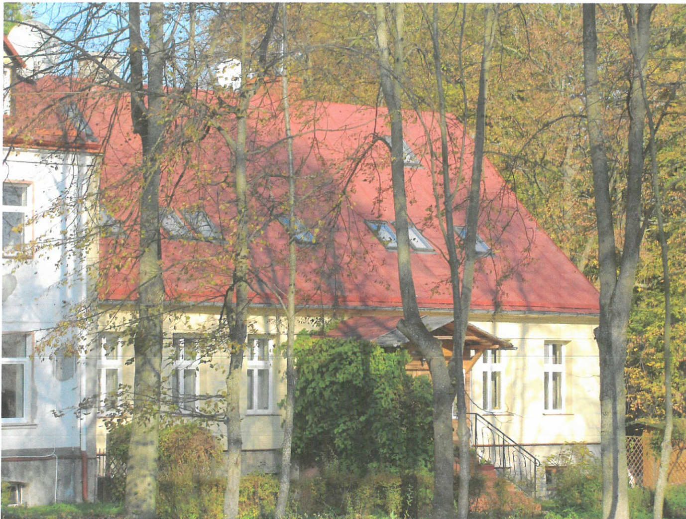
Widok ściany frontowej (z SE na NW)
