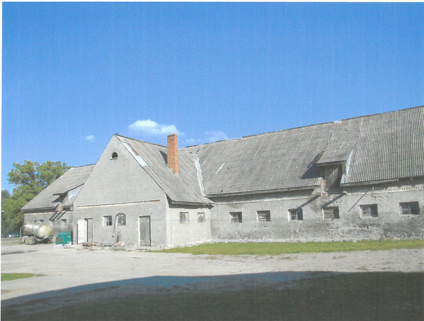
Widok ściany wzdłużnej (z SW na NE)
