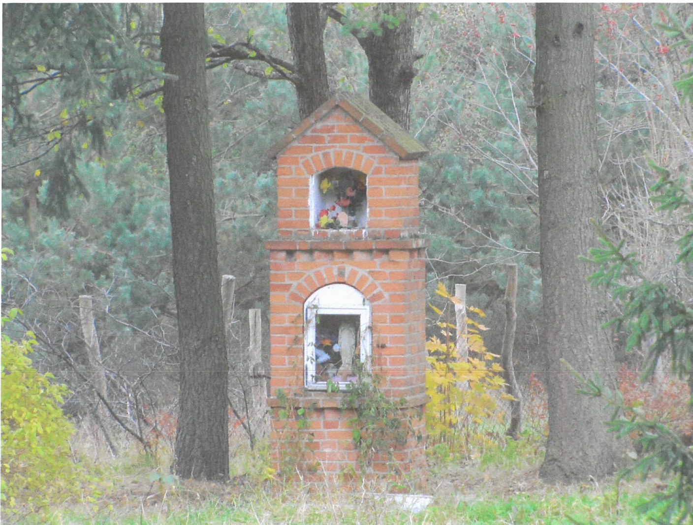
Widok ściany przedniej i bocznej (z NW na SE)
