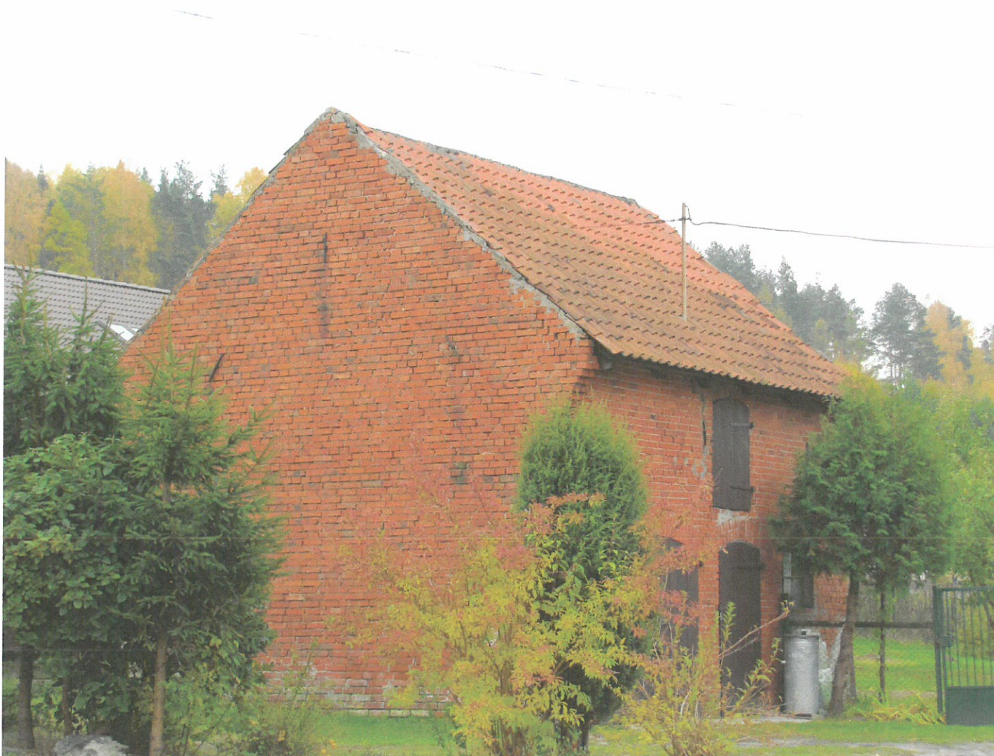
Widok ściany frontowej i szczytowej (z W na E)
