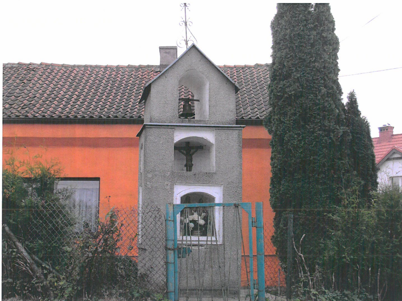
Widok ściany przedniej (z SW na NE)
