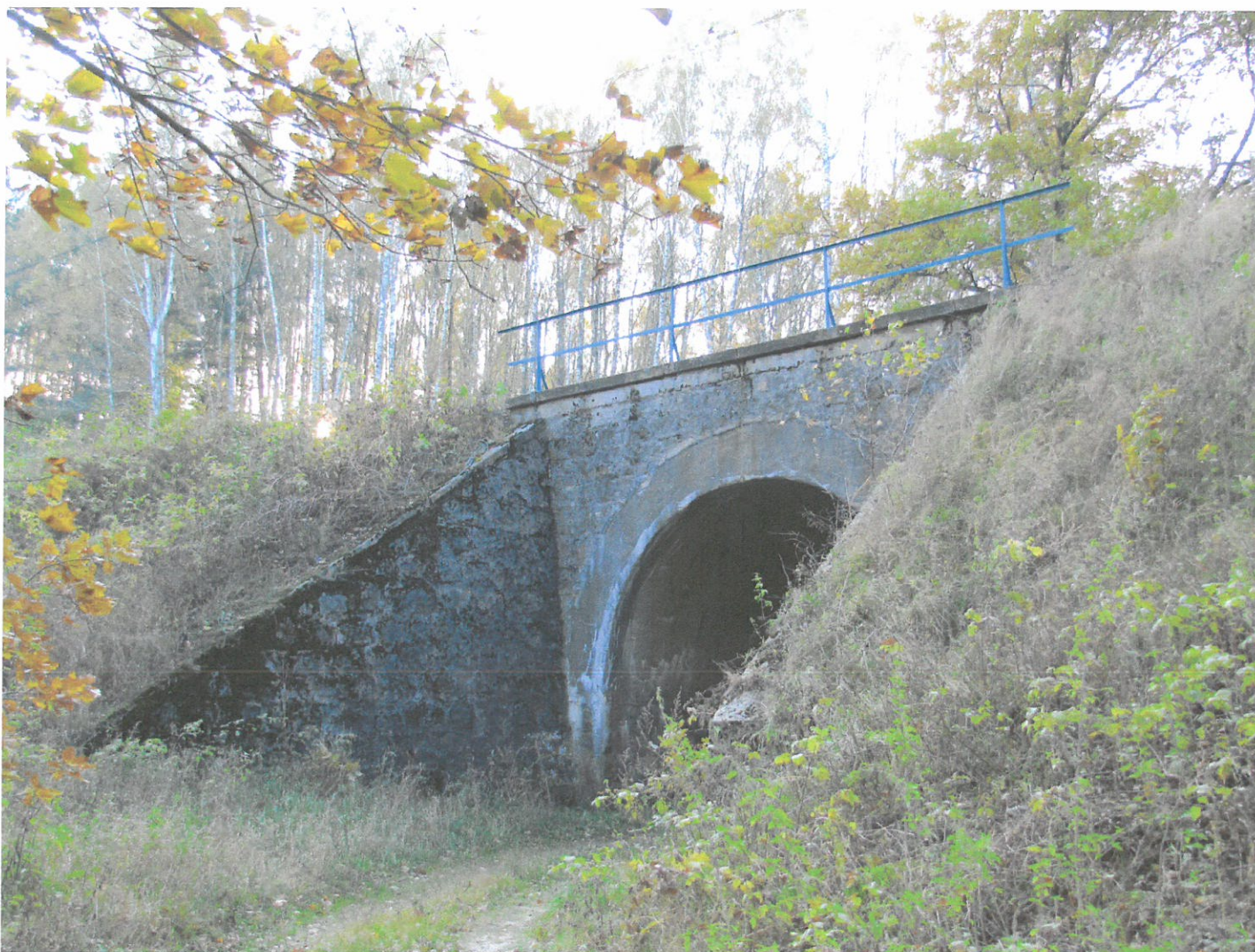
Widok ogólny wiaduktu (z E na W)
