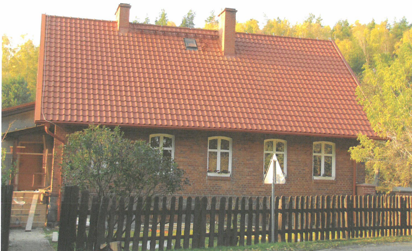
Widok ściany frontowej (z SE na NW)
