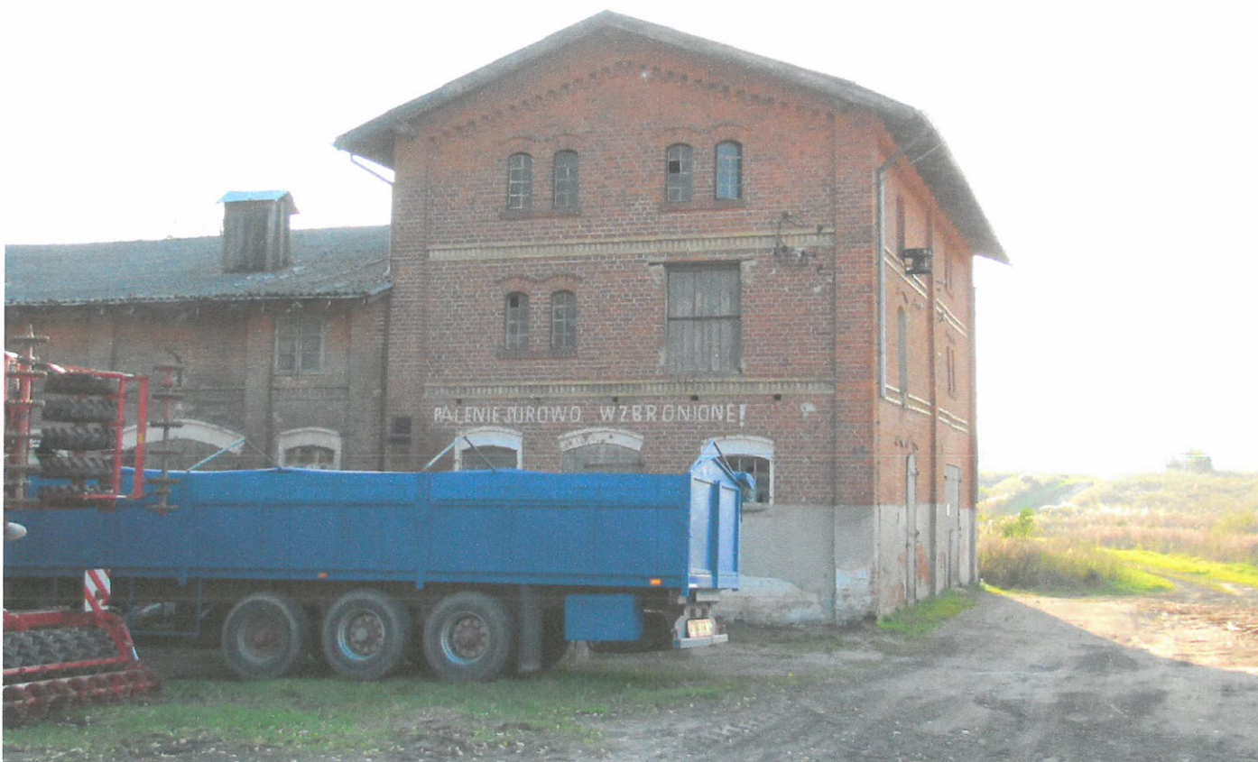
Widok ściany frontowej i bocznej (z E na W)
