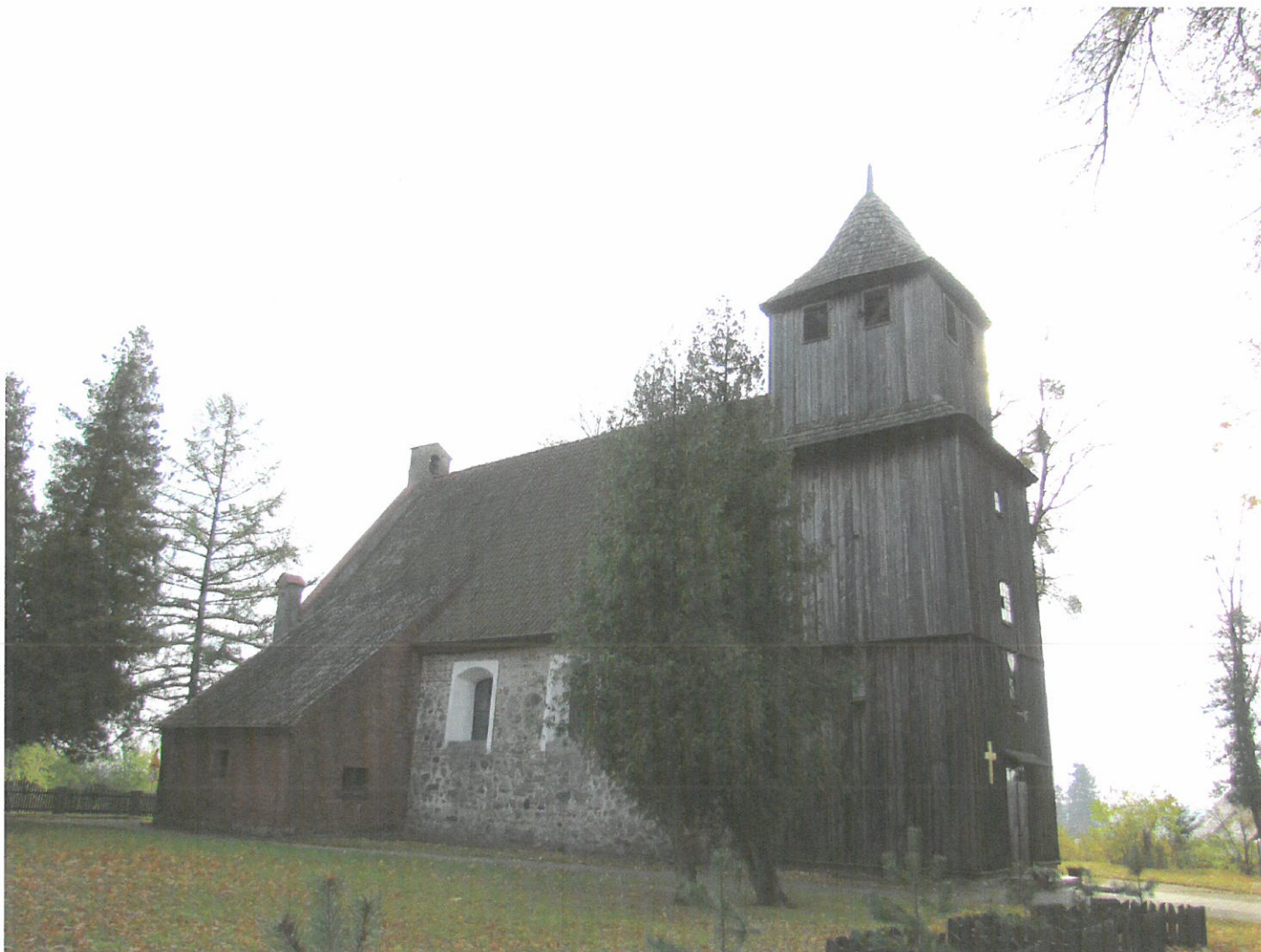
Widok ściany frontowej z dostawioną dzwonnica oraz ściany wzdłużnej (z W na E)
