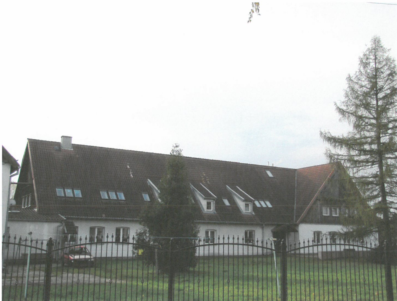
Widok ściany wzdłużnej (z W na E)
