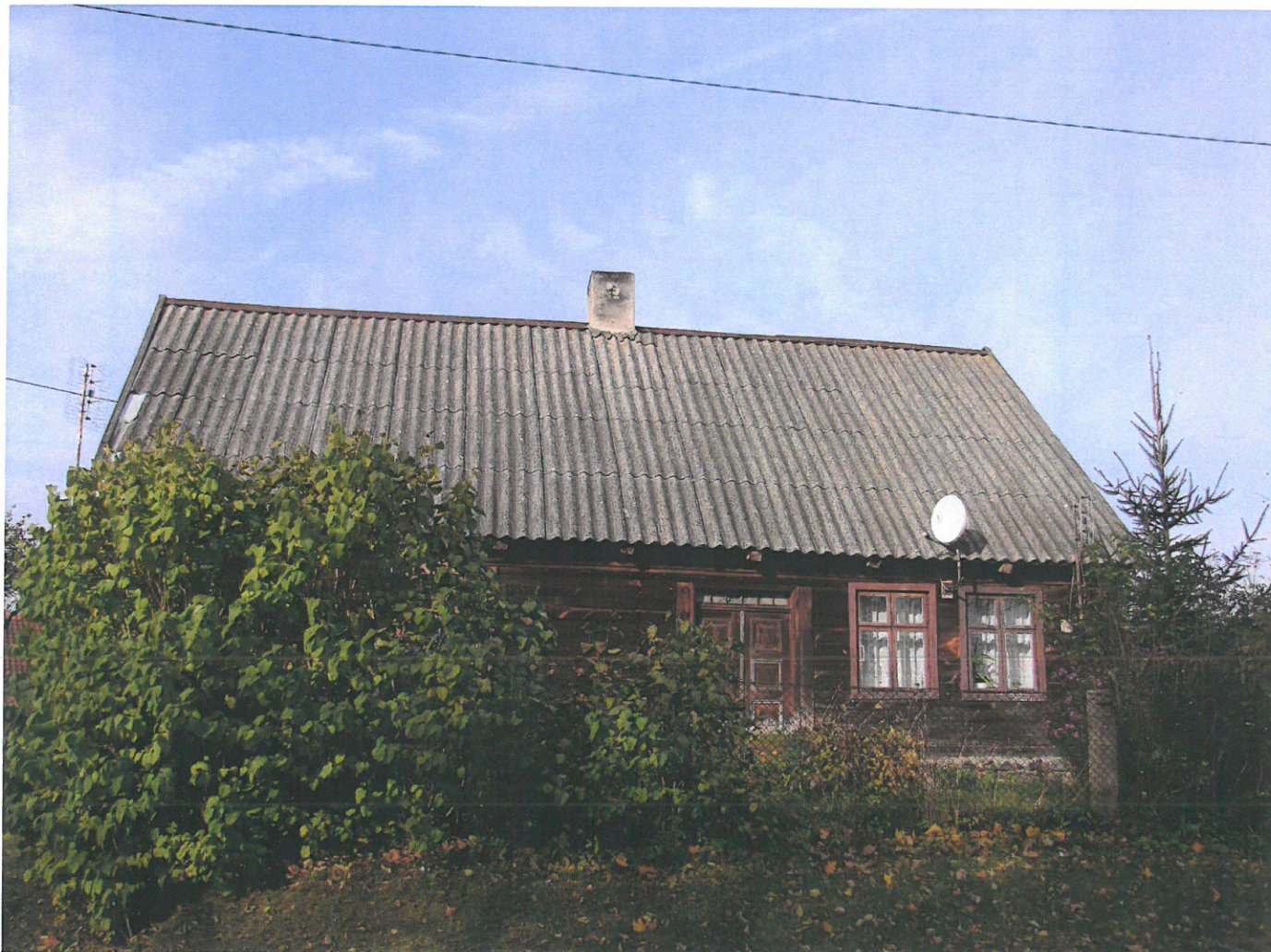
Widok ściany frontowej (z W na E)
