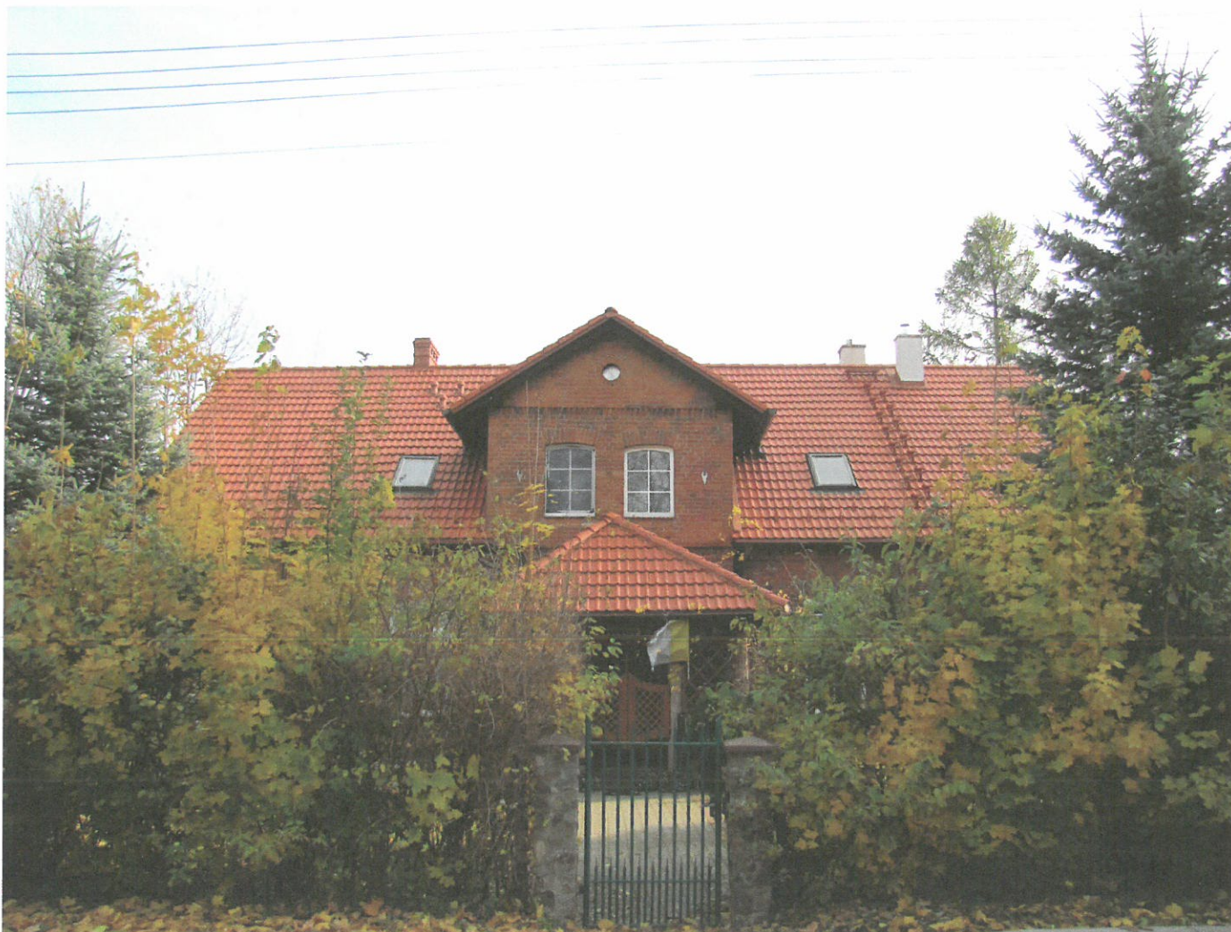
Widok ściany frontowej (z W na E)
