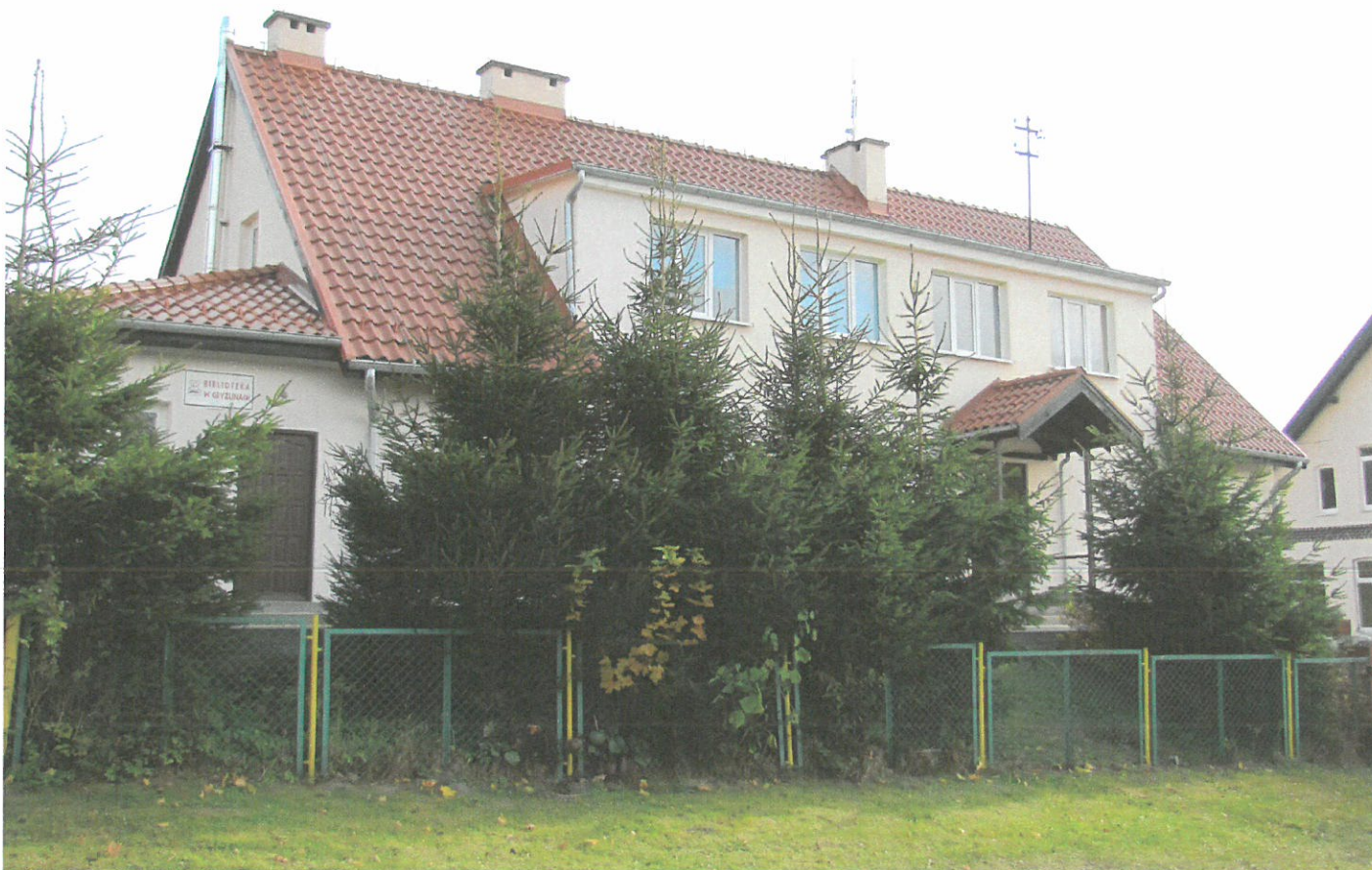
Widok ściany frontowej i szczytowej (z E na W)
