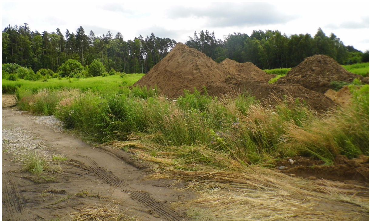
FOT 3. Teren opracowania – częściowo teren wykorzystywany jako zaplecze rozwijającej się zabudowy.
