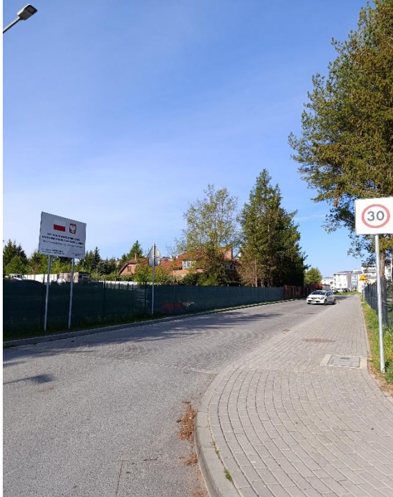
Budowa drogi gminnej ulicy Jakubowej w Jarotach
