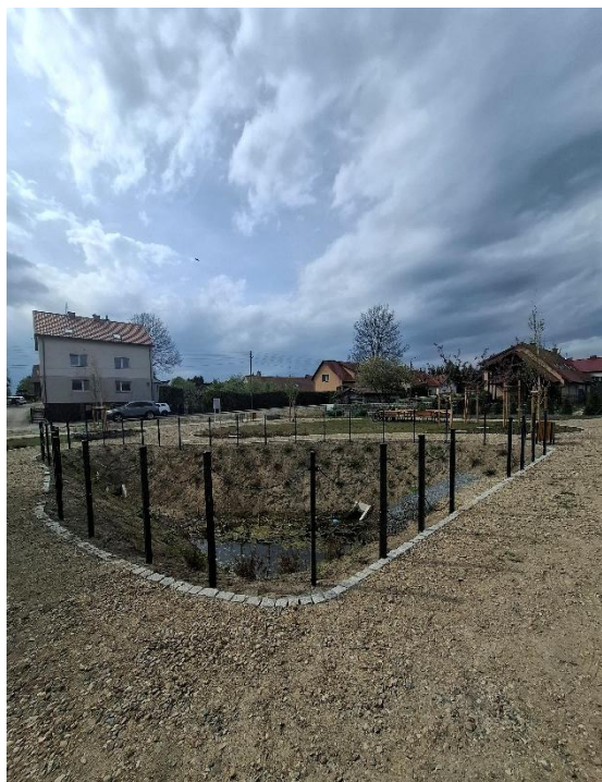
Budowa podziemnych zbiorników retencyjnych wraz z kanalizacją deszczową grawitacyjną i tłoczną w pasie drogi gminnej ul. Baczewskiego, przepompownią, ogrodzeniami i elementami zagospodarowania terenu
