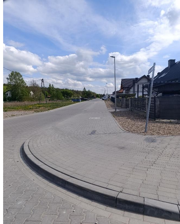
Budowa drogi gminnej w ciągu ulicy Orzechowej, Głogowej i Leszczynowej w Bartągu
