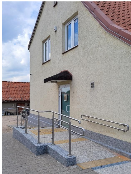
Przebudowa pochylni dla osób z niepełnosprawnościami przy budynku UG Stawiguda
